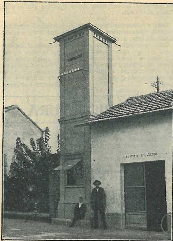
Fig. 2. — Cabina smontabile in cemento armato.
